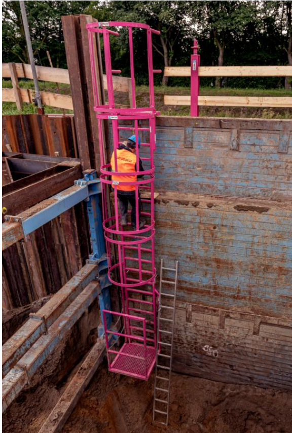
Fertig aufgebaute Verbauleiter.
